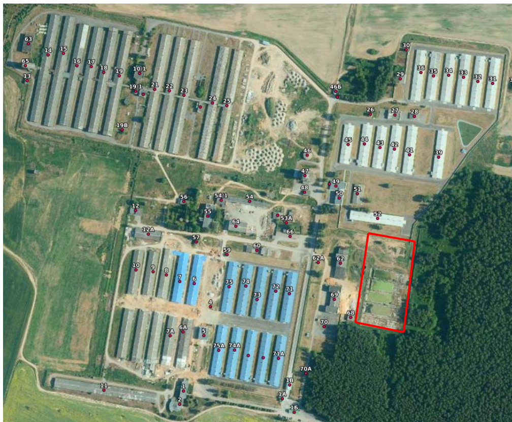
Рис.1.1 Место расположения реконструируемого объекта (вид со спутника)
